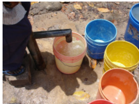
Fissaggio della pompa e qualità dell'acqua
