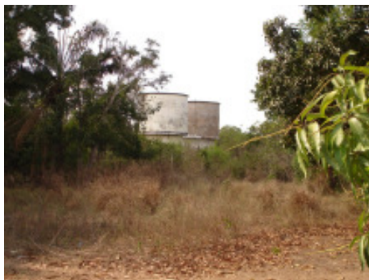
Serbatoio di raccolta dell'acqua
