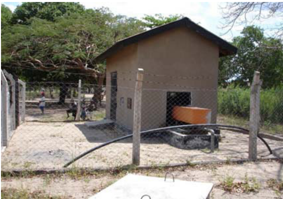
Stazione di pompaggio
