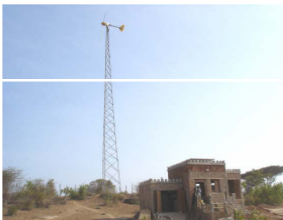
Figura: a) stazione di produzione di acqua potabile di Kizingitini. Unità di 260 l/h. Veduta della stazione che ospita l'apparecchio ad osmosi inversa e le batterie .
