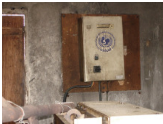
Centralina della pompa sommersa
