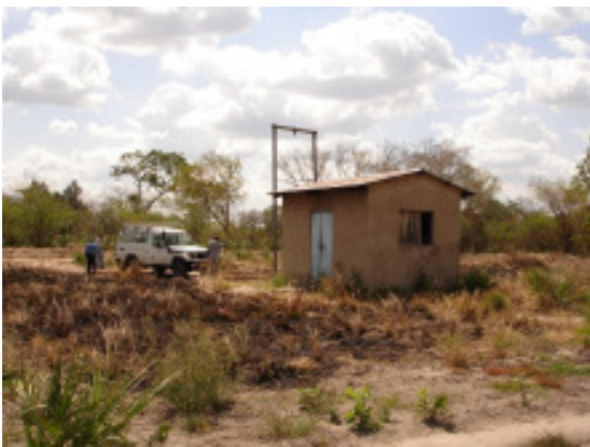
Struttura che ospita la pompa
